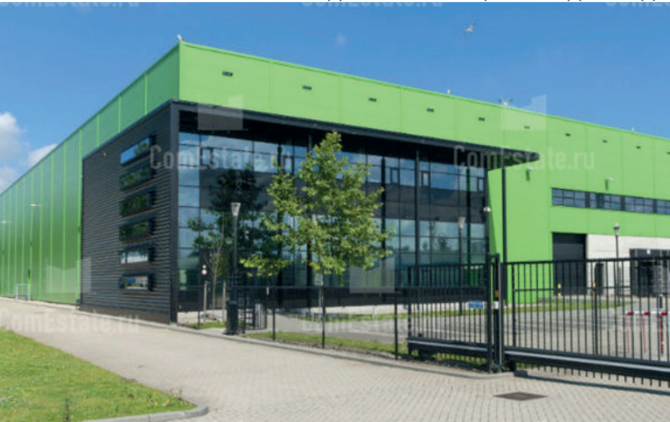
РАСПРЕДЕЛИТЕЛЬНЫЙ ЦЕНТР. НИДЕРЛАНДЫ
