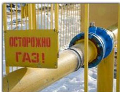
Подсоединение к сетям более высокого давления возможно лишь при наличии регулятора давления газа. Отрезок газопровода от отключающего агрегата до запорного устройства в помещении принято называть вводом, монтируемым в грунтовые земли и только в определенных случаях над землей (если газ сухой и невозможно произвести подземную разводку).
